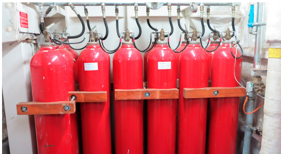
Gas-släcksystem behöver designas med 25-40% högre kapacitet mot methanol för att bibehålla konventionell säkerhetsfaktor. (Foto: Franz Evegren)
